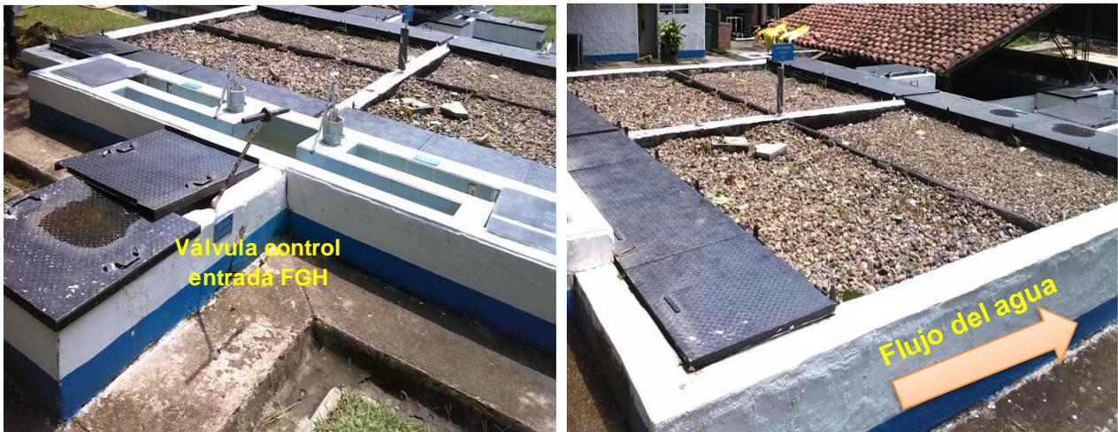
Los filtros horizontales se comunican con los filtros lentos descendentes de arena (denominados FLA 1 y FLA 2), en la entrada de estos también hay dos cámaras con válvulas y vertederos de medición diseñados para detectar fugas de agua durante el proceso de potabilización.
