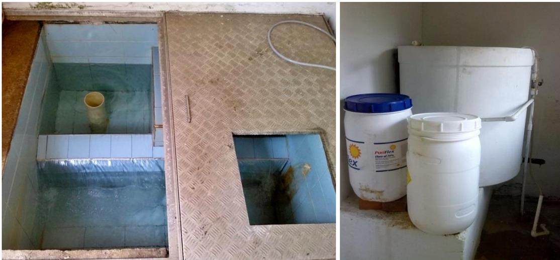
La medida de cloro usada en la planta de la Universidad, según información de la persona encargada del funcionamiento, es de 500 gramos de cloro granular por 500 litros de agua. Hay que resaltar que el cloro no es para potabilizar el agua, el agua ya es apta para consumo humano en el momento que sale de los FLA. El cloro es una barrera de desinfección, se usa debido a que el agua comienza un recorrido por tuberías que pueden contaminarla por contacto en sus paredes.
