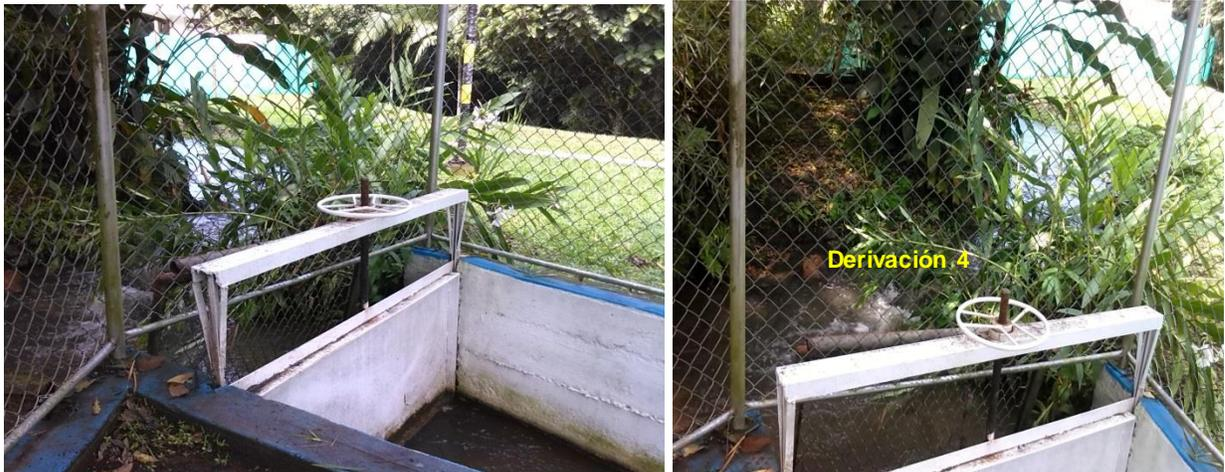
**Fotografías 2 y 2a.** Desarenador de la planta de tratamiento de agua potable de la PUJ Cali.
