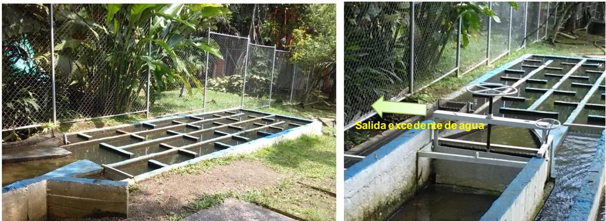
Al final del desarenador se encuentra el filtro dinámico (Fotografía 3 y 3a), el cual tiene un flujo descendente. Las dimensiones de la estructura según mediciones son las siguientes:
