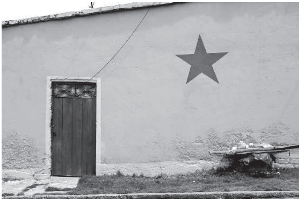
Fachada de vivienda de San Juan de Sumapaz. Foto de Nelson Cárdenas.
